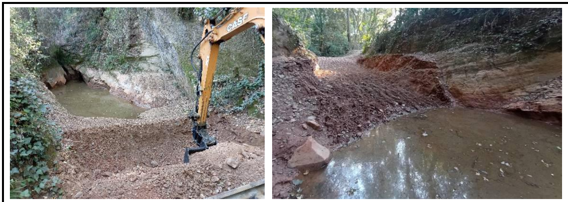
Figura 27.- Imatges d'una operació de restauració morfològica de la llera d'un riu mediterrani amb fort estiatge actualment, centrada en la recuperació de la morfologia original d'antics gorgs per a què esdevinguin de nou refugis estivals per a l'espínós i altra fauna aquàtica amenaçada. En concret, es tracta del gorg de la riera de Sant Miquel, a la conca del Galligans, dins el TM de Girona, i al peu de les Gavarres. En aquest tram, ja s'hi ha dut a terme una operació de reintroducció exitosa de l'espínós. Fotos: Associació la Sorellona.
