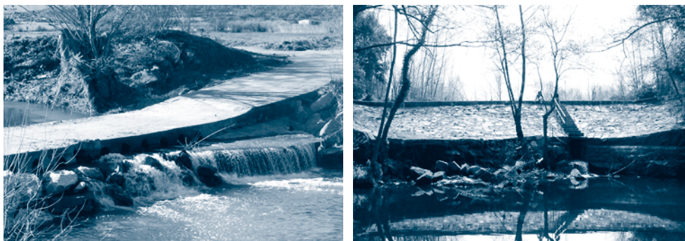
Figura 13. Infraestructures que intercepten els cursos fluvials i que suposen un obstacle per als moviments dels peixos
